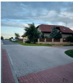
Rekonstrukce komunikace V Průhonu-Louňovická
