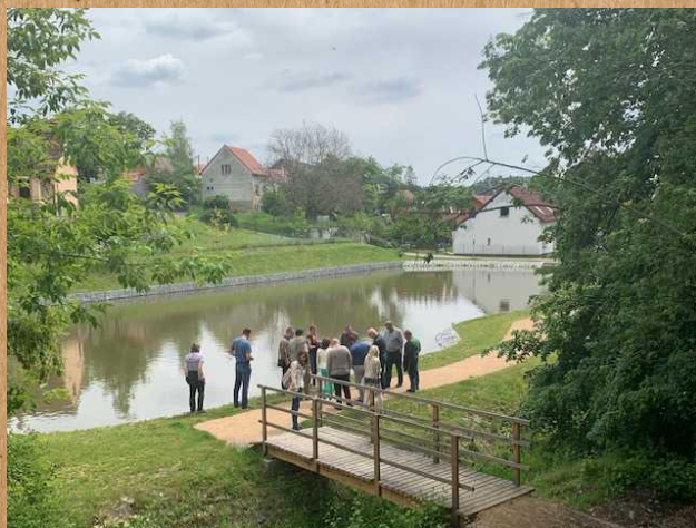
Opravená požární nádrž s upraveným malým parkem
